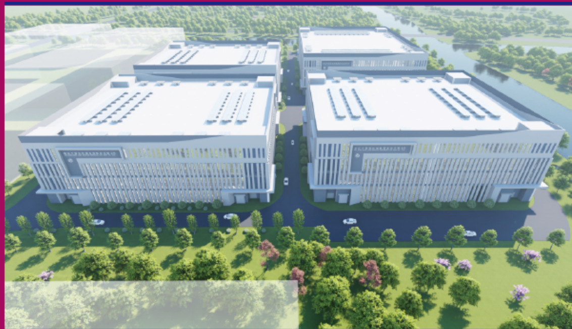
轻纺智谷数字工业园区建设项目（一期工程）EPC 总承包项目效果图
