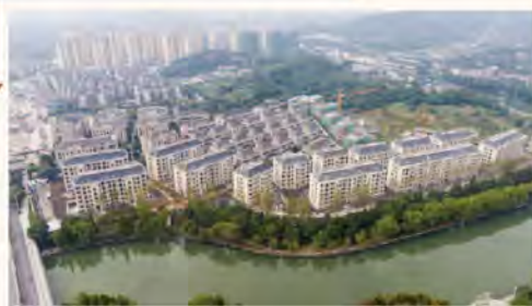
30#~46#楼主体全部封顶；
