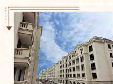
35#~42#楼排水管已完成；
