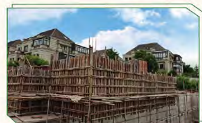
43#~46#排屋地下室完成；
