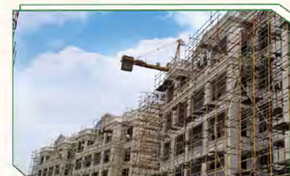
37#~39#楼涂料、石材基本完成；
