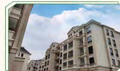
30#~34#楼门窗、栏杆完成；
