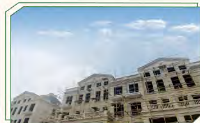
35#~42#楼二层~五层石材窗套完成；
